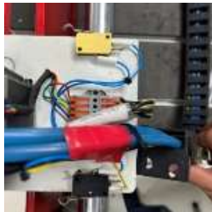
(ก) การติดตั้งลิ้มิตสวิตช์เพื่อ จำกัดขอบเขตแกน X
